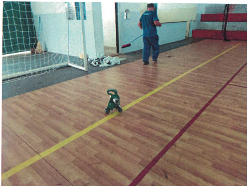
Figura 12 - piso recolado conforme orientação técnica
