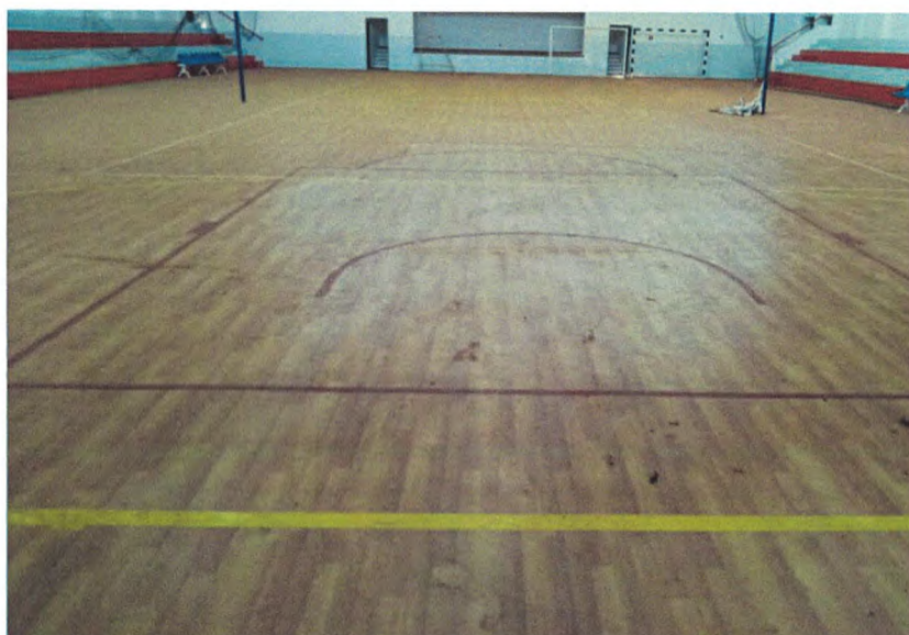
Figura 13 - piso recolado conforme orientação técnica
