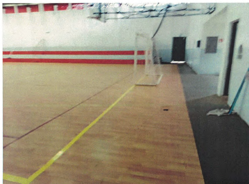
Figura 11 - piso recolado conforme orientação técnica
