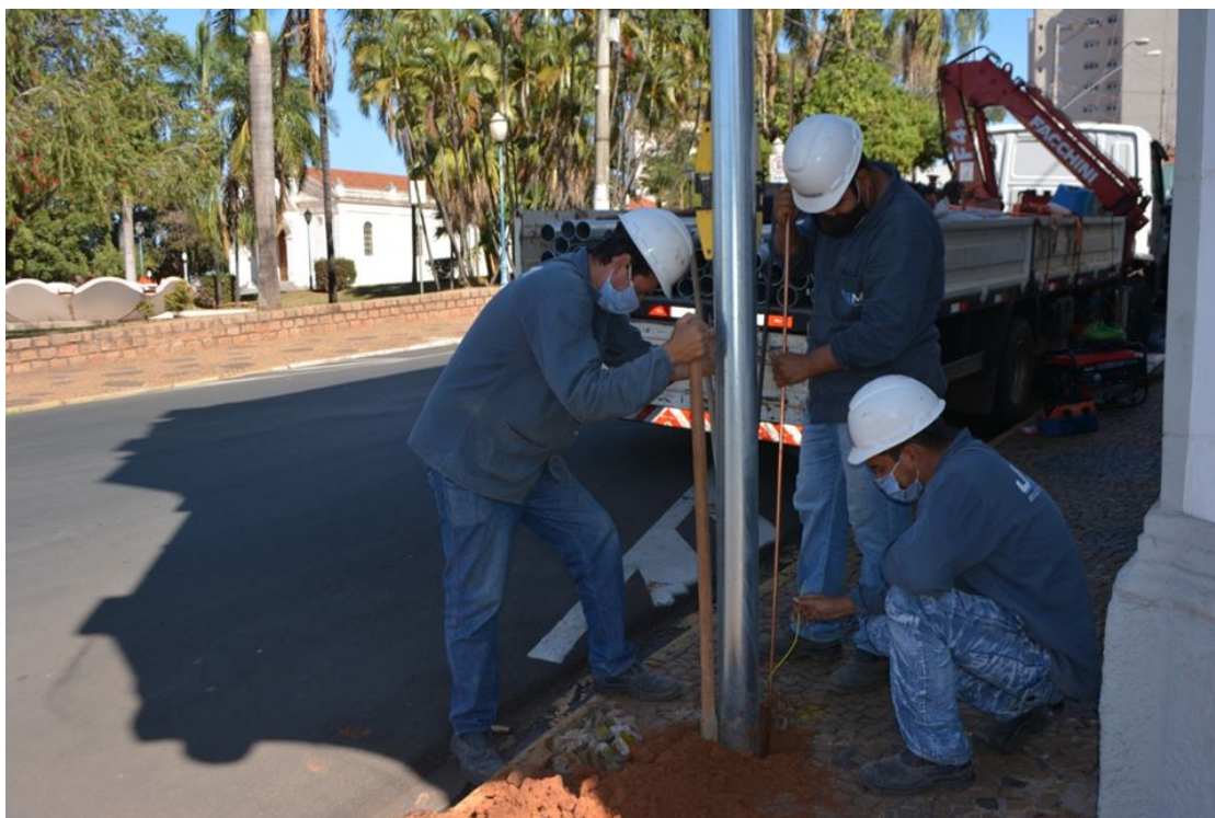
Equipamentos sendo instalados no cruzamento da Rua Campos Sales, na esquina da Praça "Dr. Horácio Ramalho" – Foto: AIPMT
