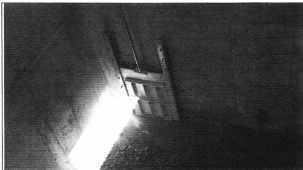
Descrição: Vista interna da Caixa de Fluxo 2.
