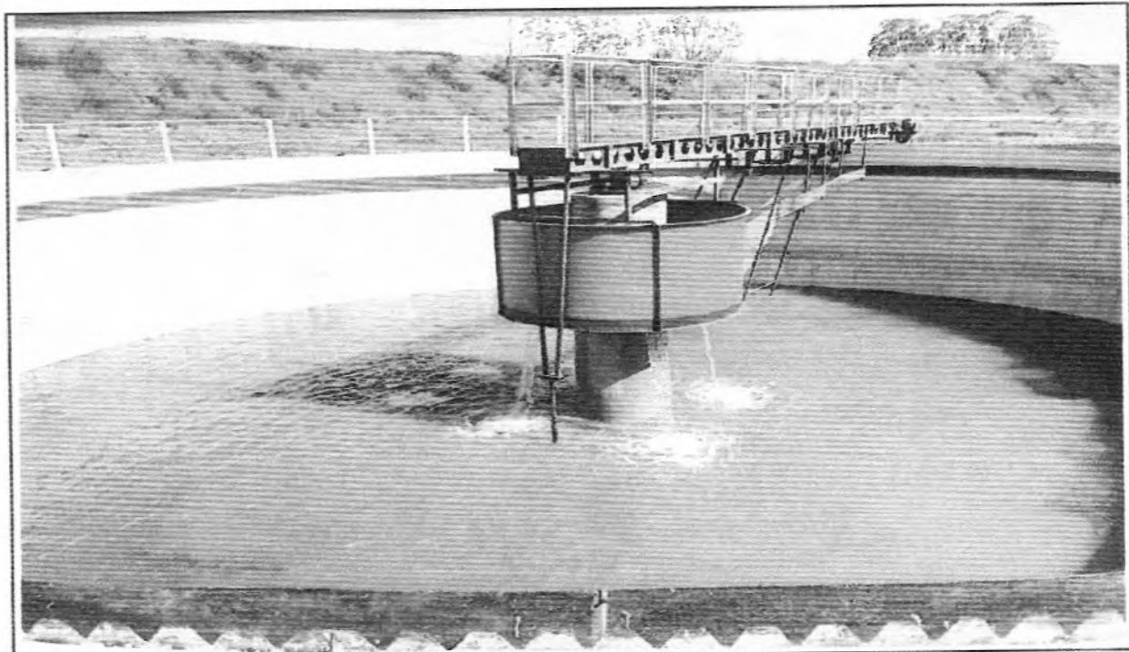
Descrição: Início do enchimento do Decantador 2.
