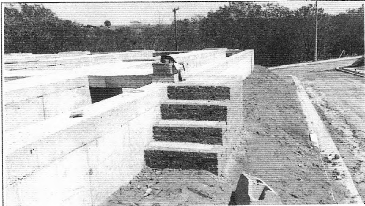
Descrição: Execução da escada de acesso da laje do Reator 1
