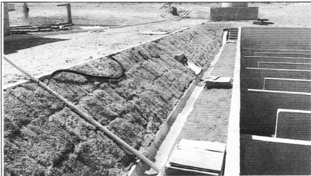
Descrição: Regularização do talude e plantio de grama no entorno do Tanque de Contato
