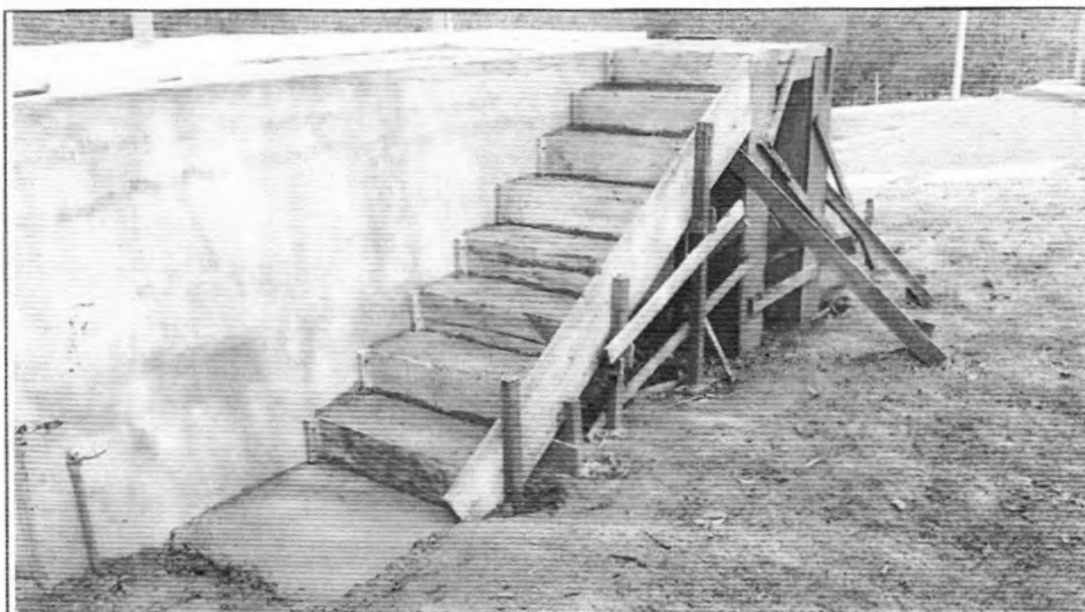
Descrição: Concretagem da escada da Caixa de Fluxo 1
