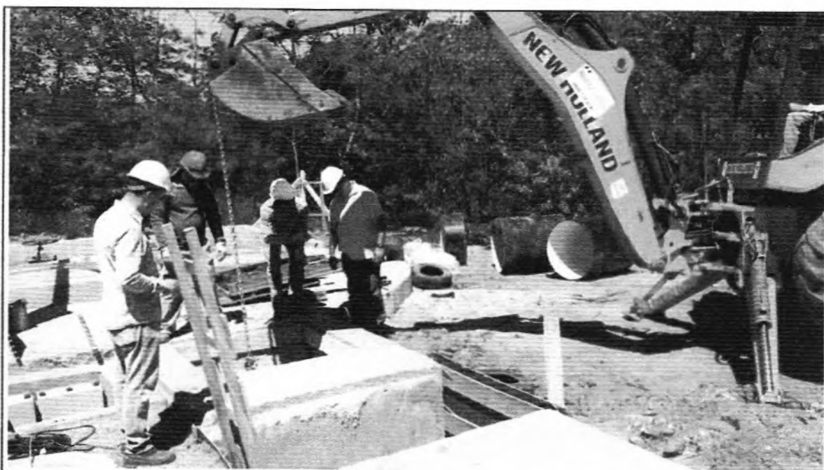
Descrição: Assentamento da tubulação da caixa de entrada de efluente para EE Final.
