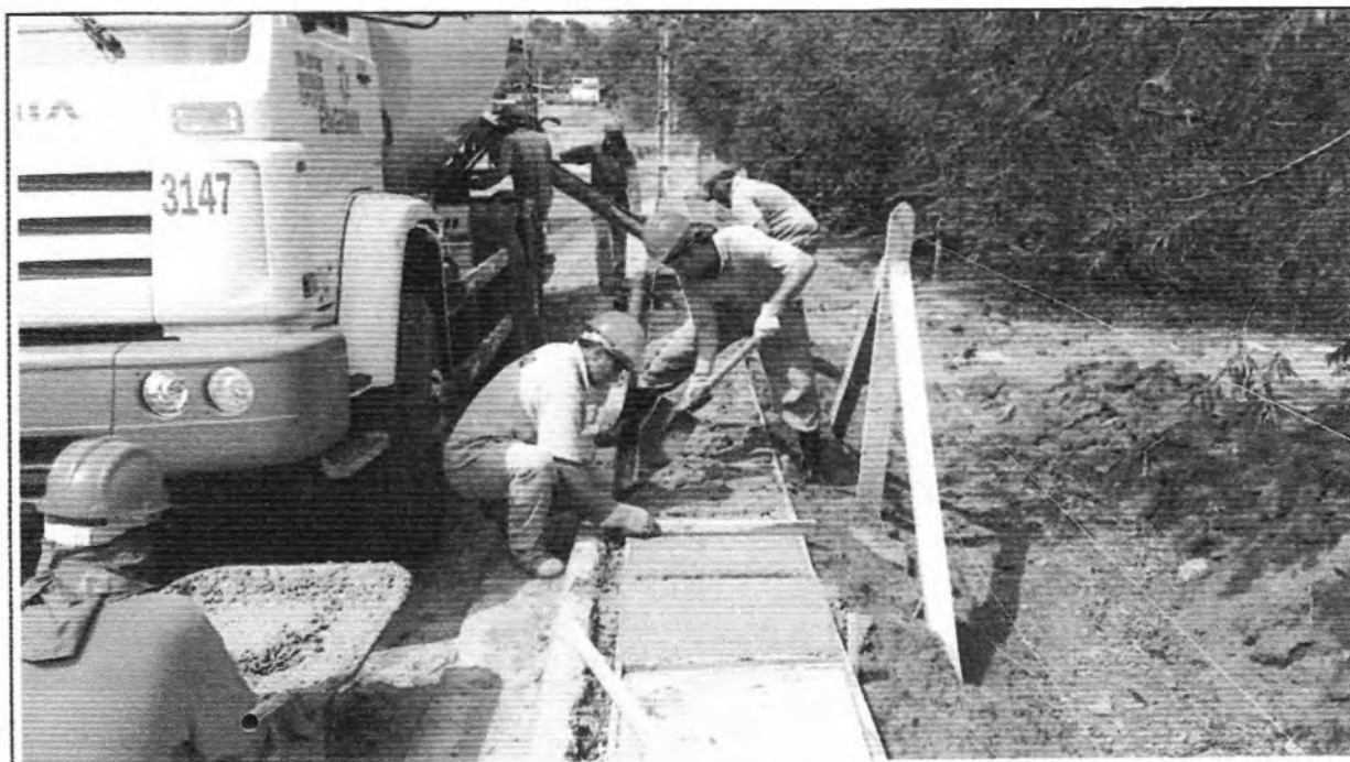
Descrição: Concretagem da calçada na rua principal da ETE.
