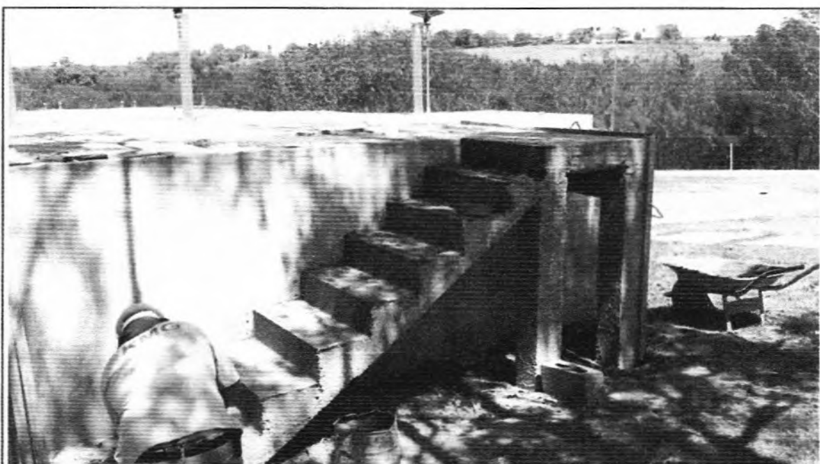
Descrição: Reboco da escada da Caixa de Fluxo 1.
