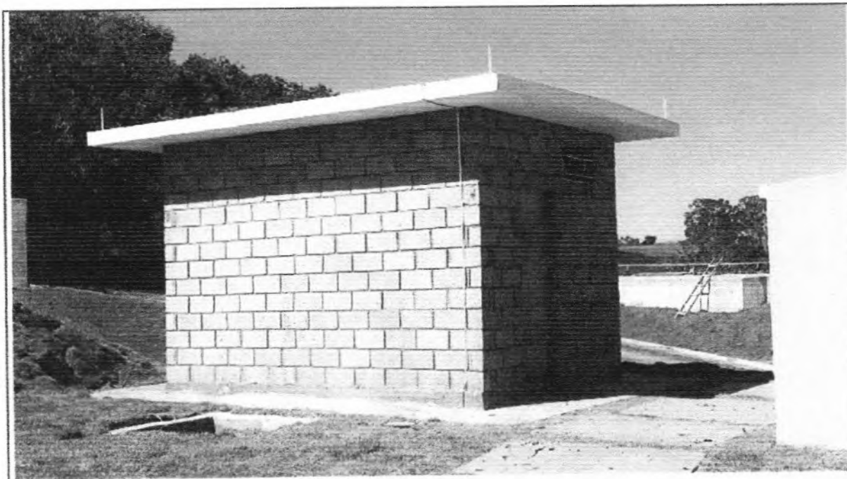
Descrição: Vista lateral da Casa de Painel 2.
