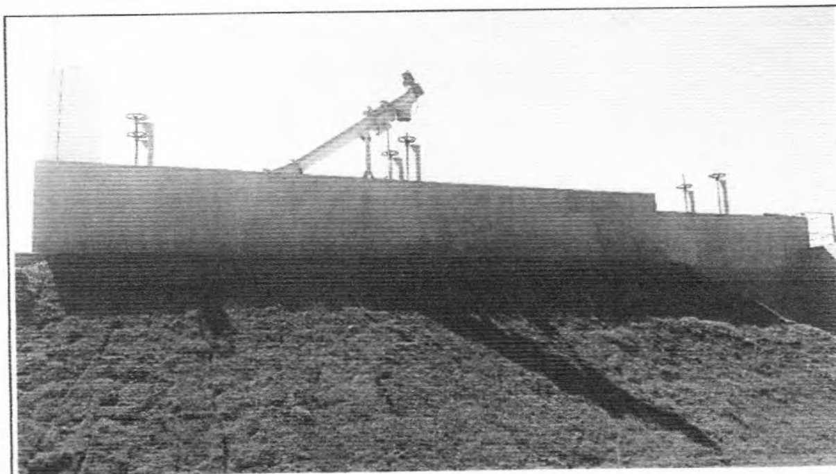
Descrição: Vista lateral do Desarenador.
