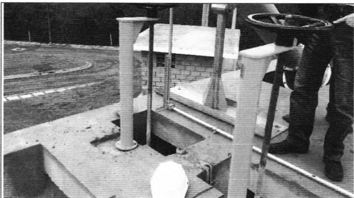
**Descrição:** Instalação das hastes do volante do Desarenador.
