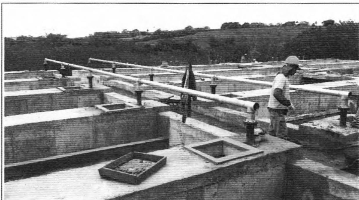
**Descrição:** Assentamento da tubulação do queimador de gás dos Reatores 1 e 2.
