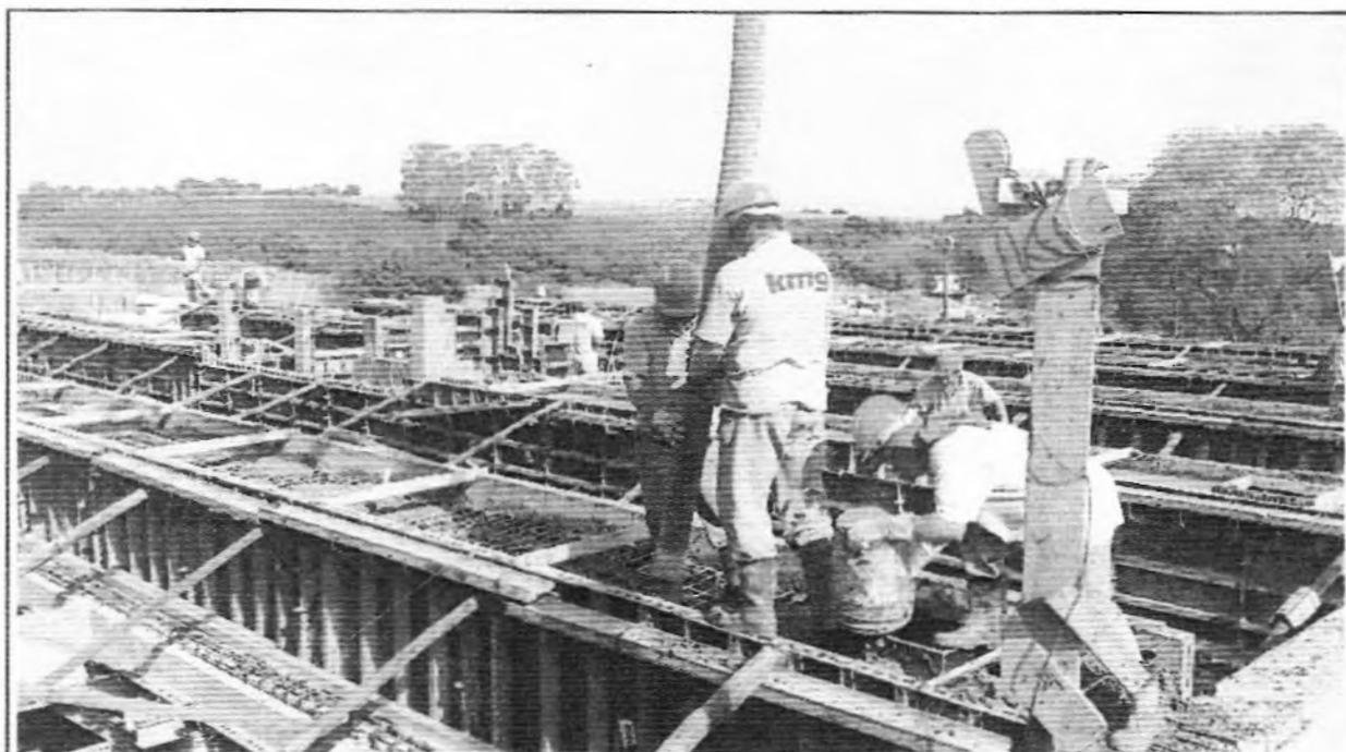
**Descrição:** Concretagem das vigas "J" (parte superior) e laje do Reator 2
