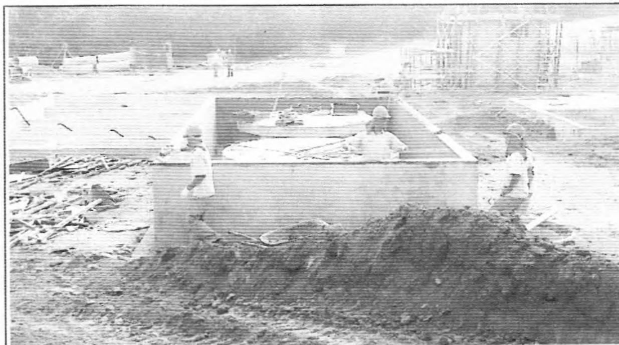
**Descrição:** Execução das paredes da bacia de contenção dos Tanques de Hipoclorito de Sódio.
