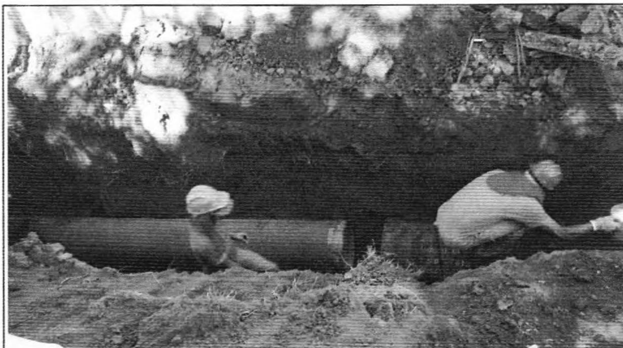
**Descrição:** Assentamento da tubulação da entra de efluente da Caixa de Fluxo1 ao Reator 2
