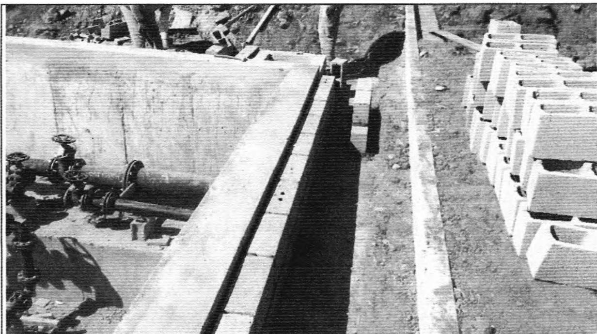
**Descrição:** Execução da canaleta de contenção da EE de Recirculação
