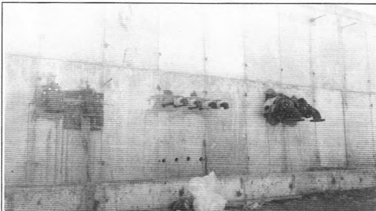
**Descrição:** Assentamento da tubulação da coleta de amostra de lodo do Reator 1
