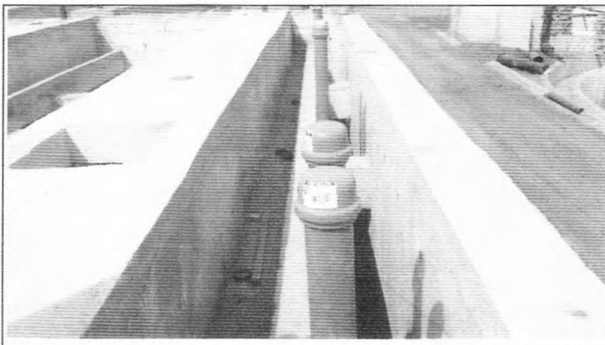
**Descrição:** Assentamento da tubulação de saída de lodo dos Reatores
