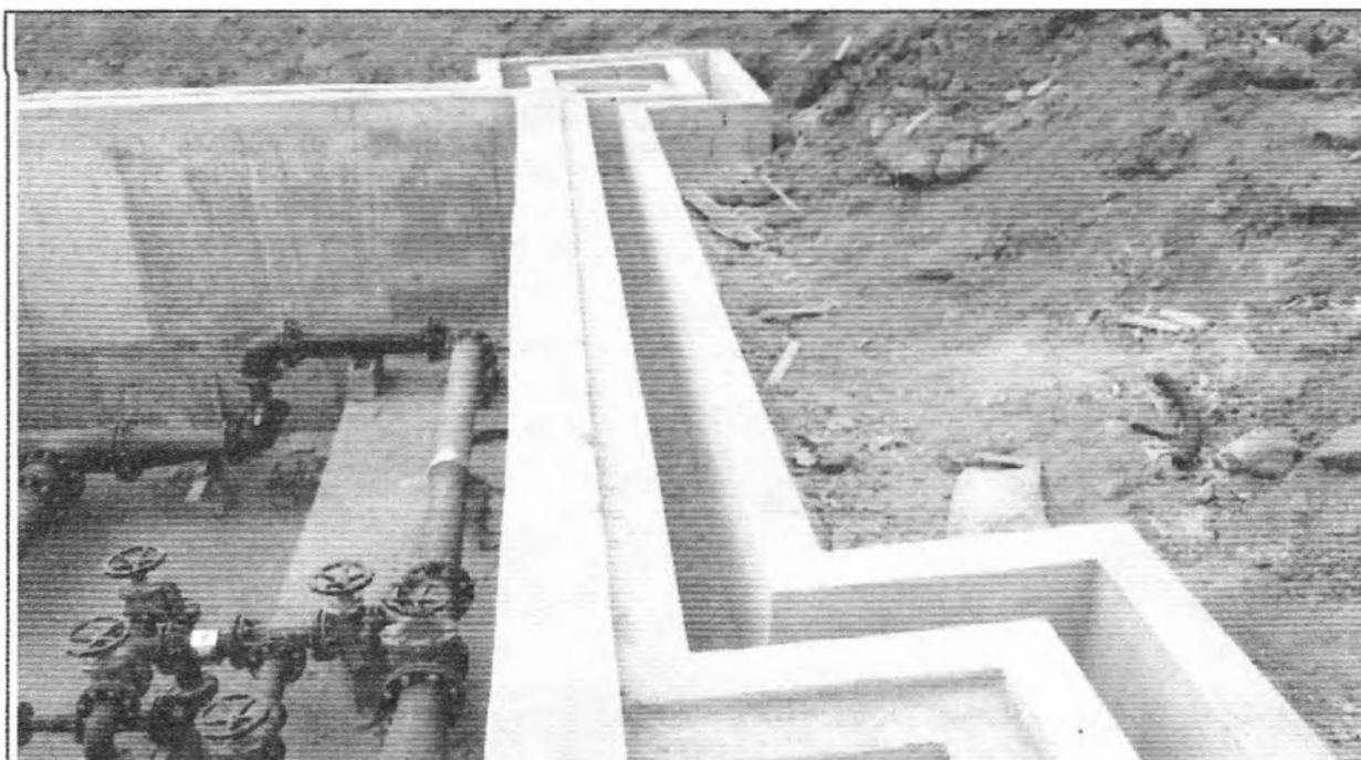
**Descrição:** Execução da canaleta de contenção no entorno da EE Recirculação.
