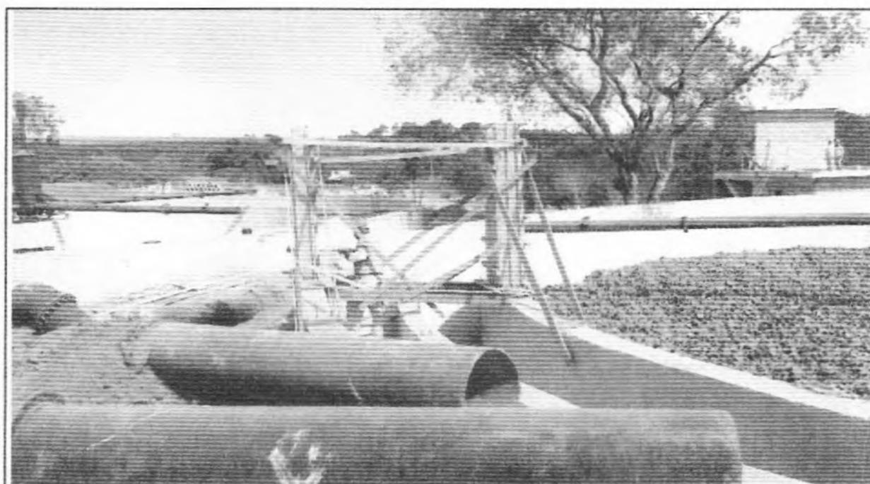
**Descrição:** Armadura e forma dos pilaretes do extravasor do Filtro 1.
