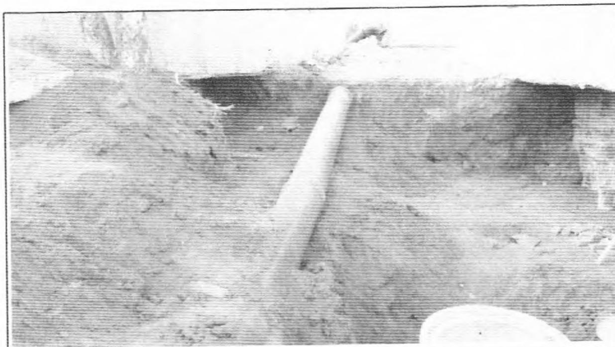
**Descrição:** Assentamento da tubulação saída da derivação da Caixa de Fluxo 2
