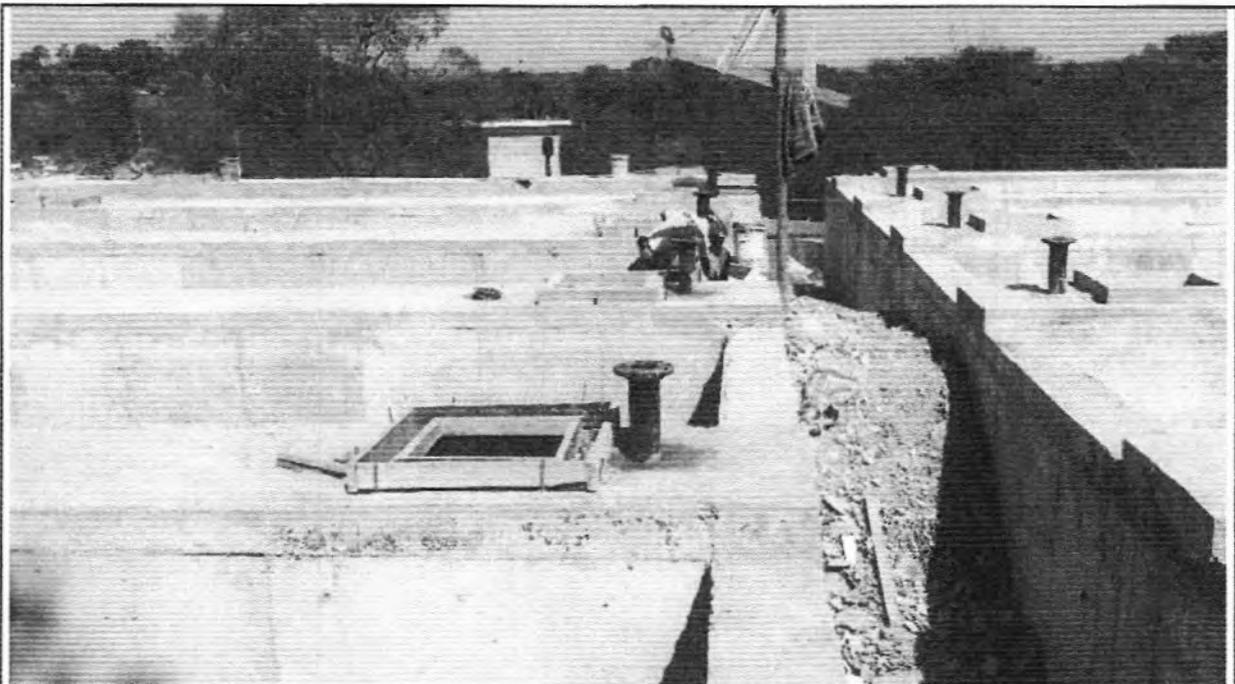
**Descrição:** Assentamento da tubulação dos queimadores de gases dos Reatores 1 e 2.
