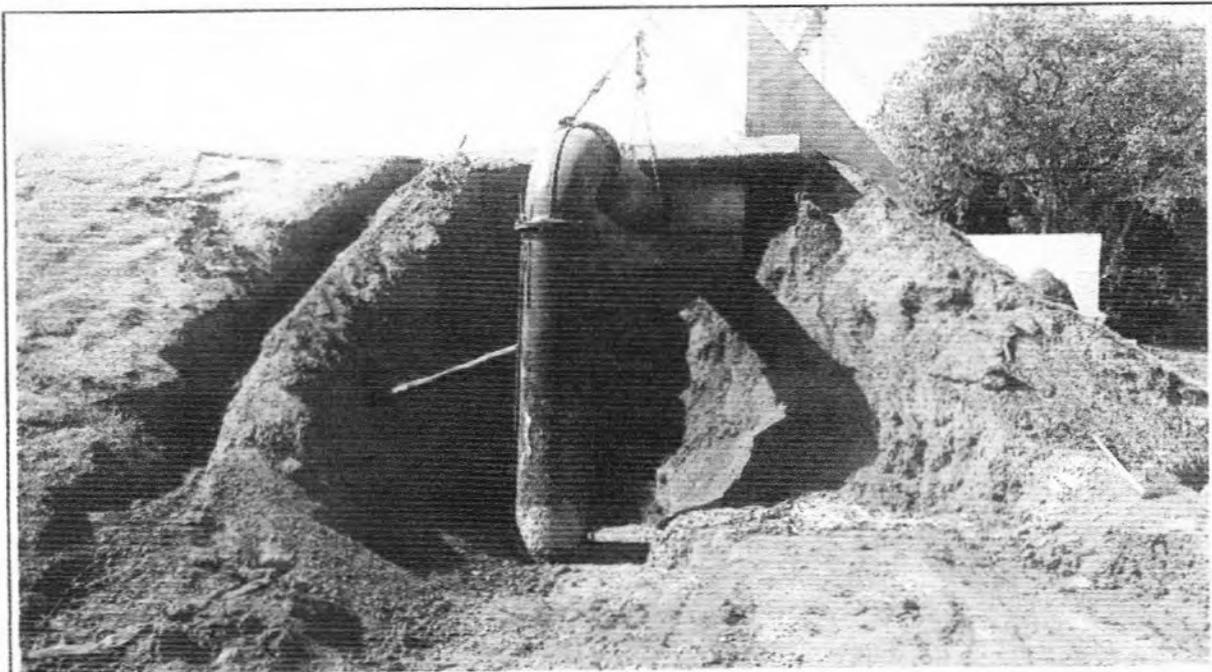
**Descrição:** Assentamento da tubulação ( F°F° - Ø 500 - L=10,00 m) da EE Final ao Desarenador.
