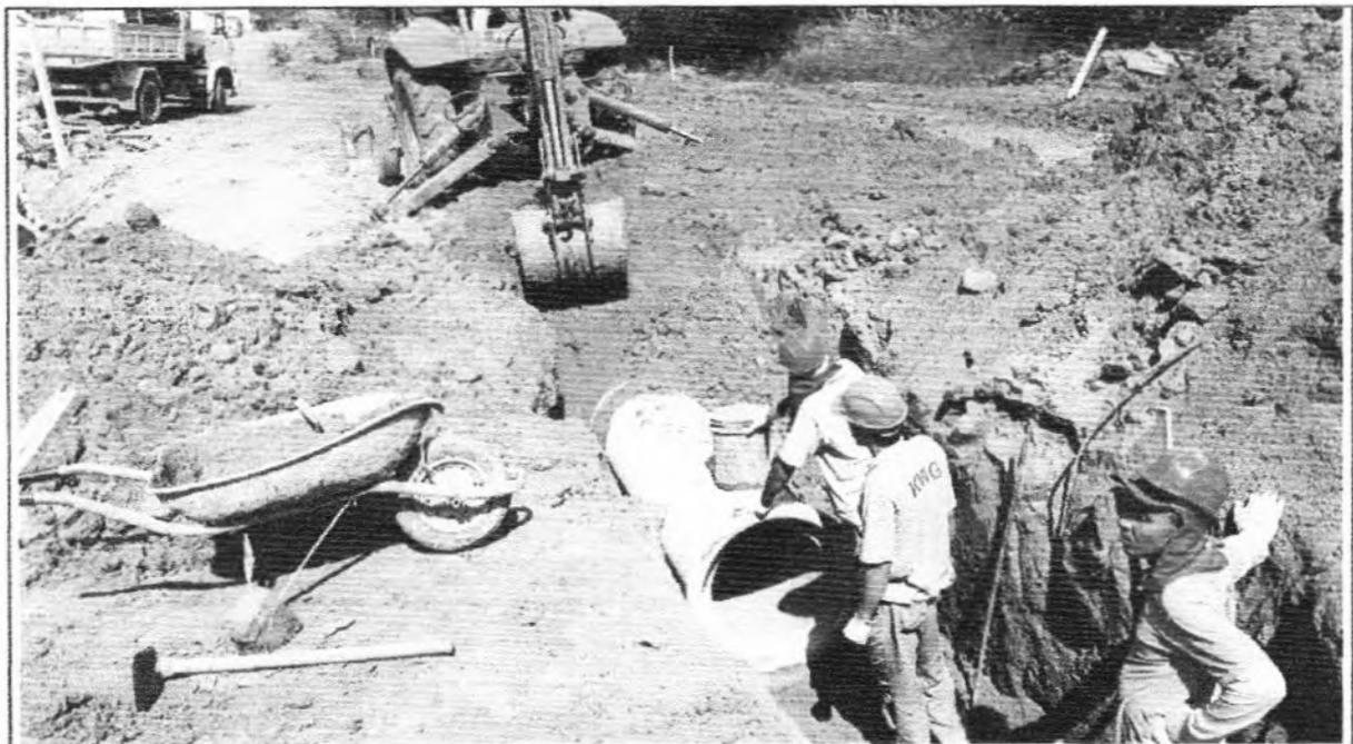
**Descrição:** Galeria de Água Pluvial (CA - Ø 0,60 m).
