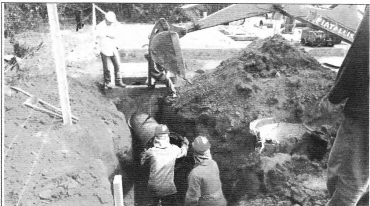
**Descrição:** Montagem do barrilete da EE Final (Aço Carbono - Ø100 mm - L= 30,00m).
