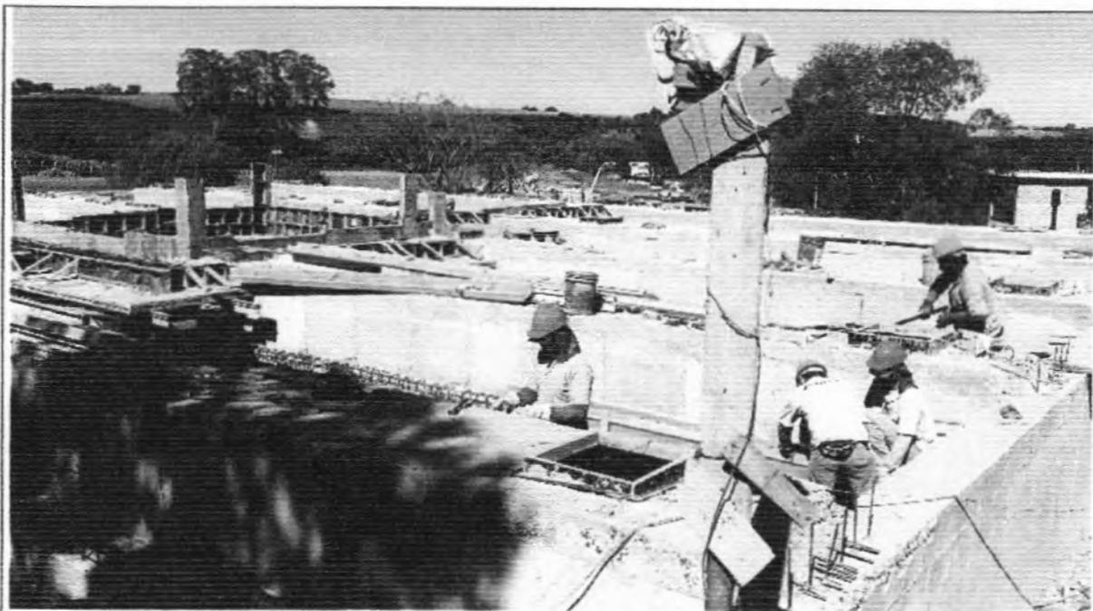
**Descrição:** Concretagens das lajes, canaletas e distribuidor central do Reator 2
