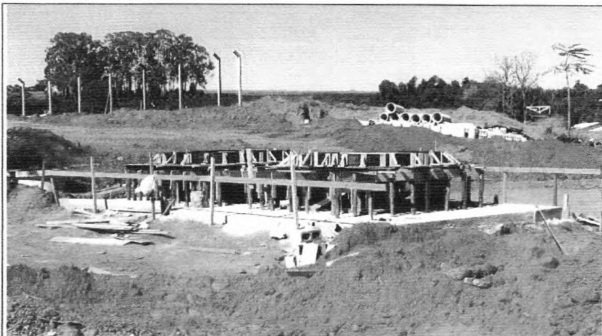
**Descrição:** Montagens de armaduras e formas da laje dos Tanques de Hipoclorito.
