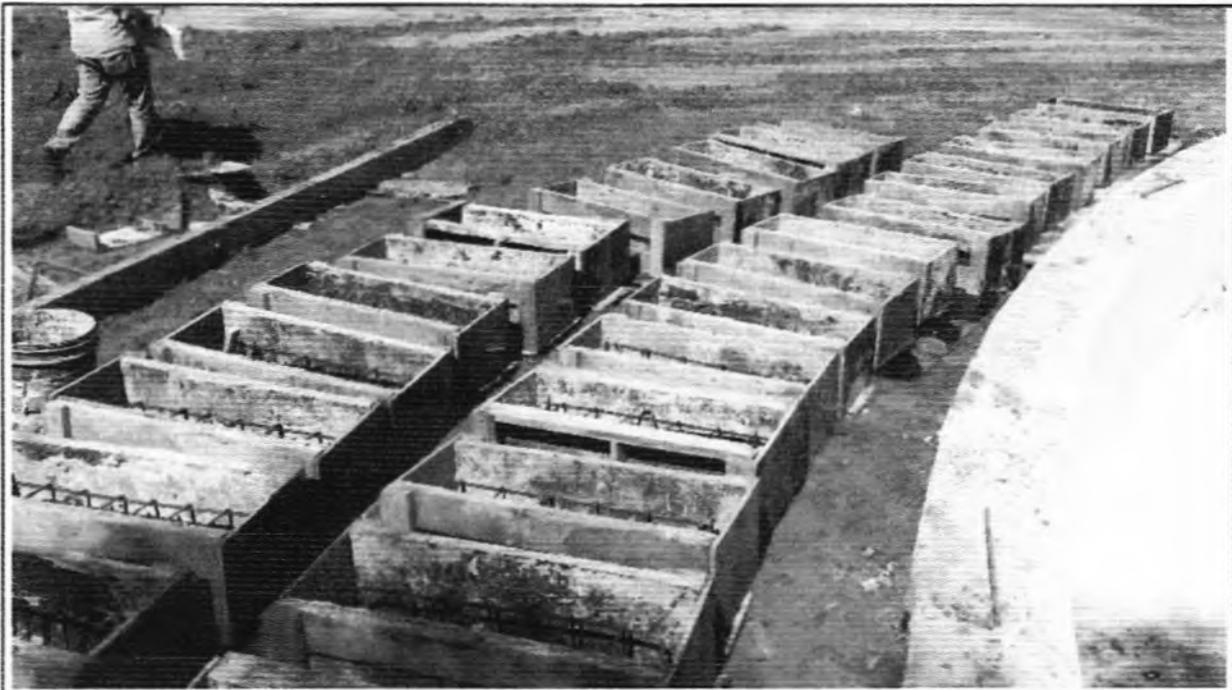
**Descrição:** Armadura e concretagem dos pilares do Filtro 2.
