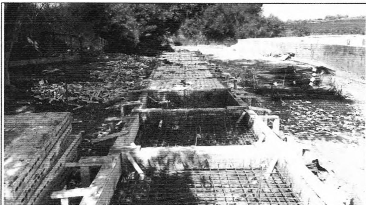
**Descrição:** Armadura e concretagem das placas dos Filtros.
