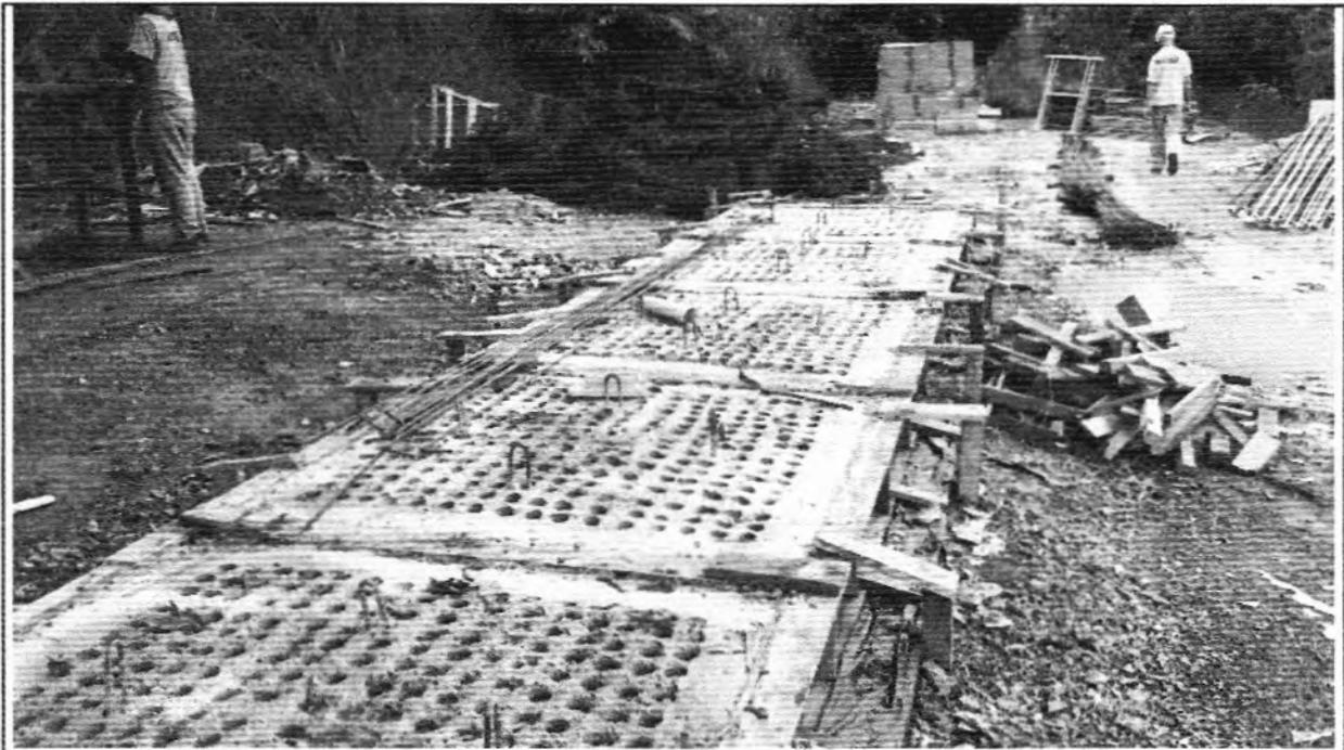
**Descrição:** Concretagem dos pilaretes e das placas dos Filtros 1 e 2.
