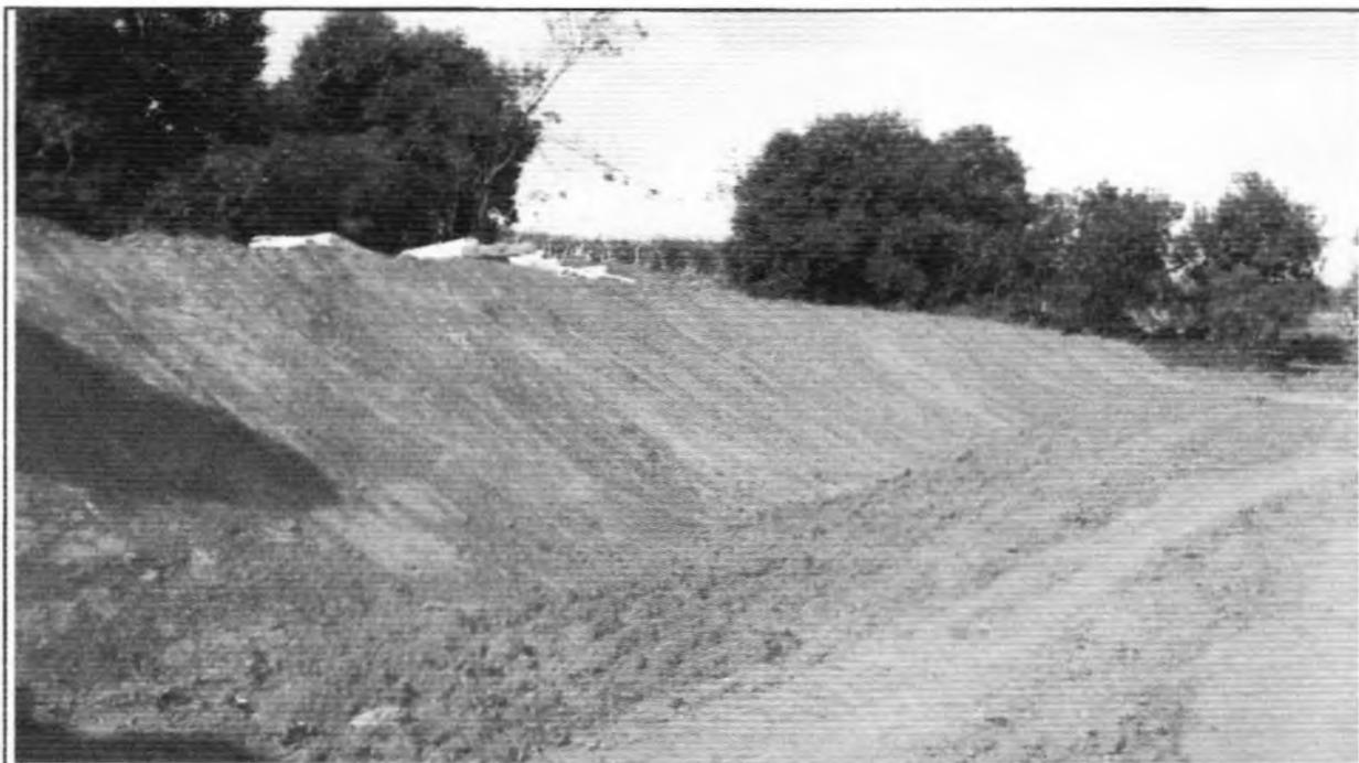
**Descrição:** Regularização do talude em torno do Reator 2.
