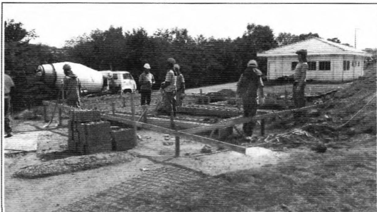
**Descrição:** Concretagem da base da Casa do Painel do Desarenador.
