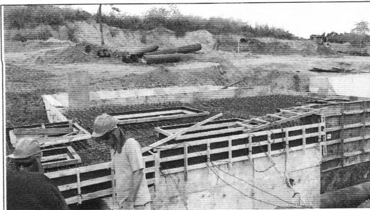
**Descrição:** Armadura e montagem de forma da laje da EE Recirculação.
