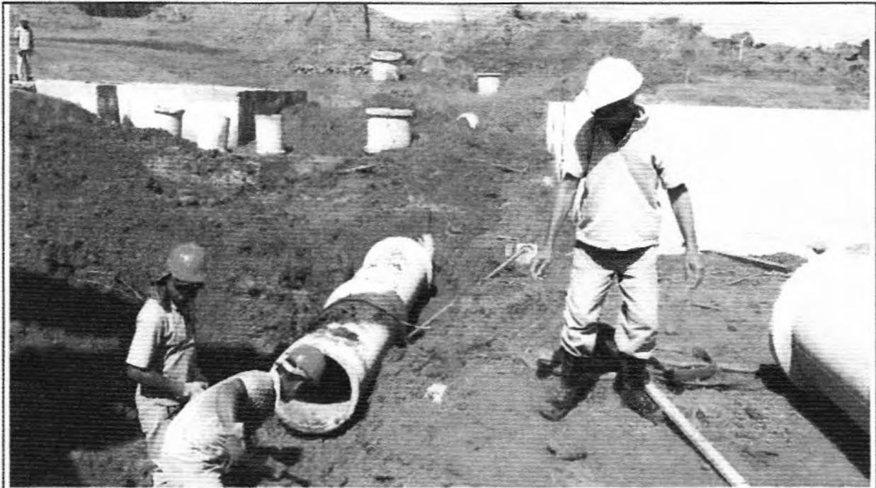
**Descrição:** Assentamento da tubulação (Concreto armado - Ø 600 mm) na rua entre EE Recirculação e Tanque de Contato.
