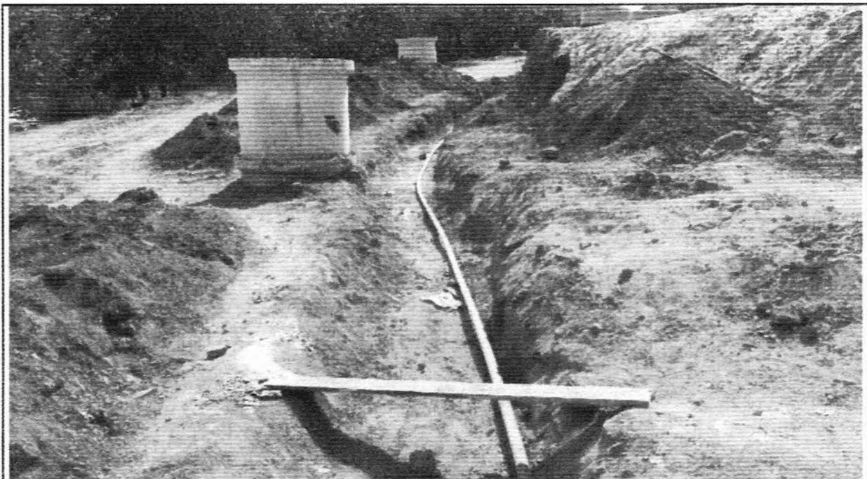
**Descrição:** Assentamento da tubulação (PVC - Ø 50 mm) da Caixa D'Água a Casa Desidratação de Lodo.
