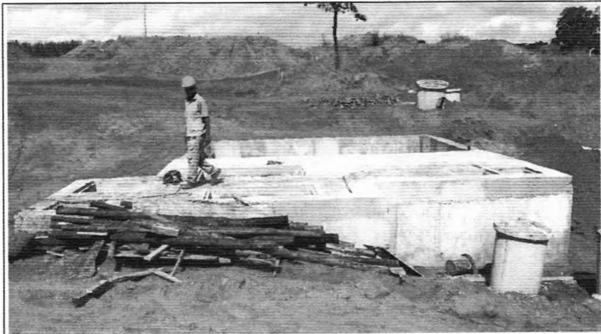
**Descrição:** Assentamento da tubulação (F°F°) da Caixa de Fluxo 1 ao Reator 1.
