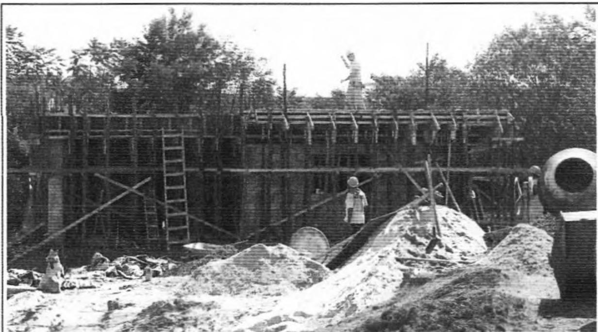
**Descrição:** Armadura e montagem de formas da laje da Casa Desidratação de Lodo.
