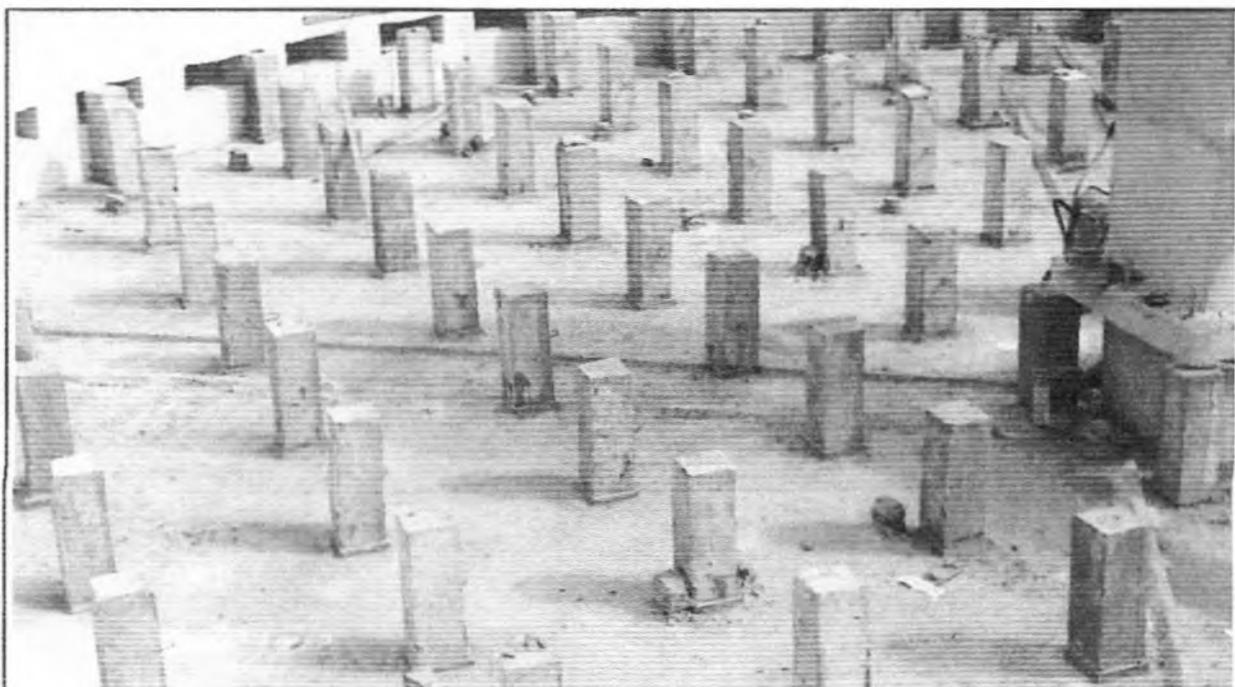
**Descrição:** Chumbamento dos pilaretes pré moldados de concreto do Filtro 2.
