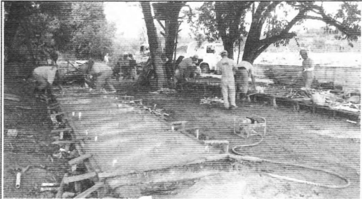
**Descrição:** Concretagem das placas e pilaretes do Filtro 2.
