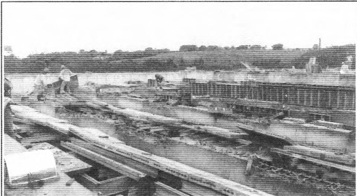
**Descrição:** Montagem de formas das vigas "J" do Reator 2.
