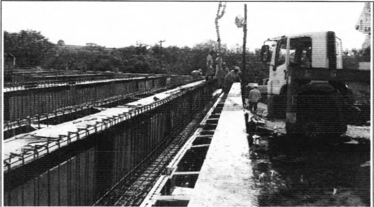
**Descrição:** Concretagem das canaletas internas de saída de efluente do Reator 1.
