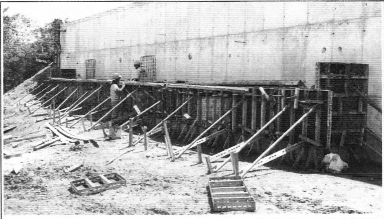
**Descrição:** Montagem da forma da caixa de espuma do Reator 1.
