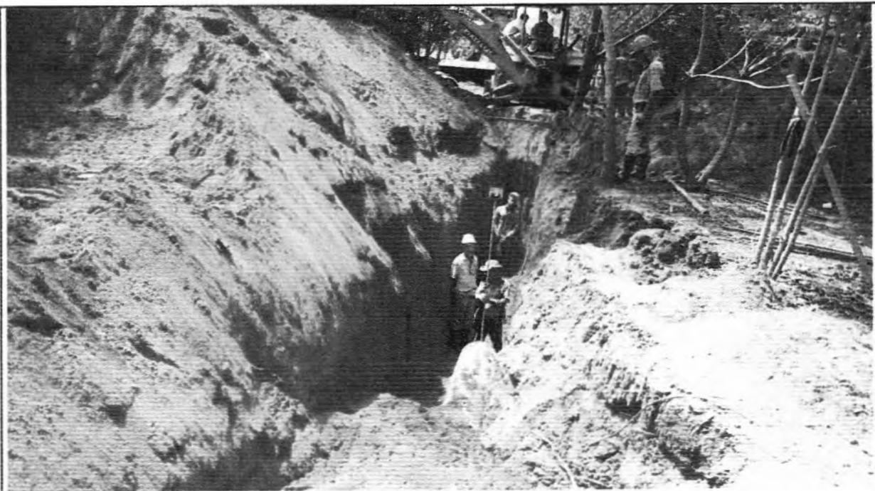
**Descrição:** Execução da linha de recalque da EE Final / Tratamento Preliminar
