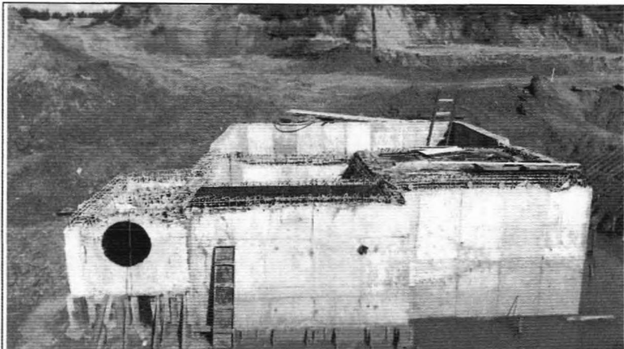
**Descrição:** Montagem de forma da laje da EE de Recirculação.
