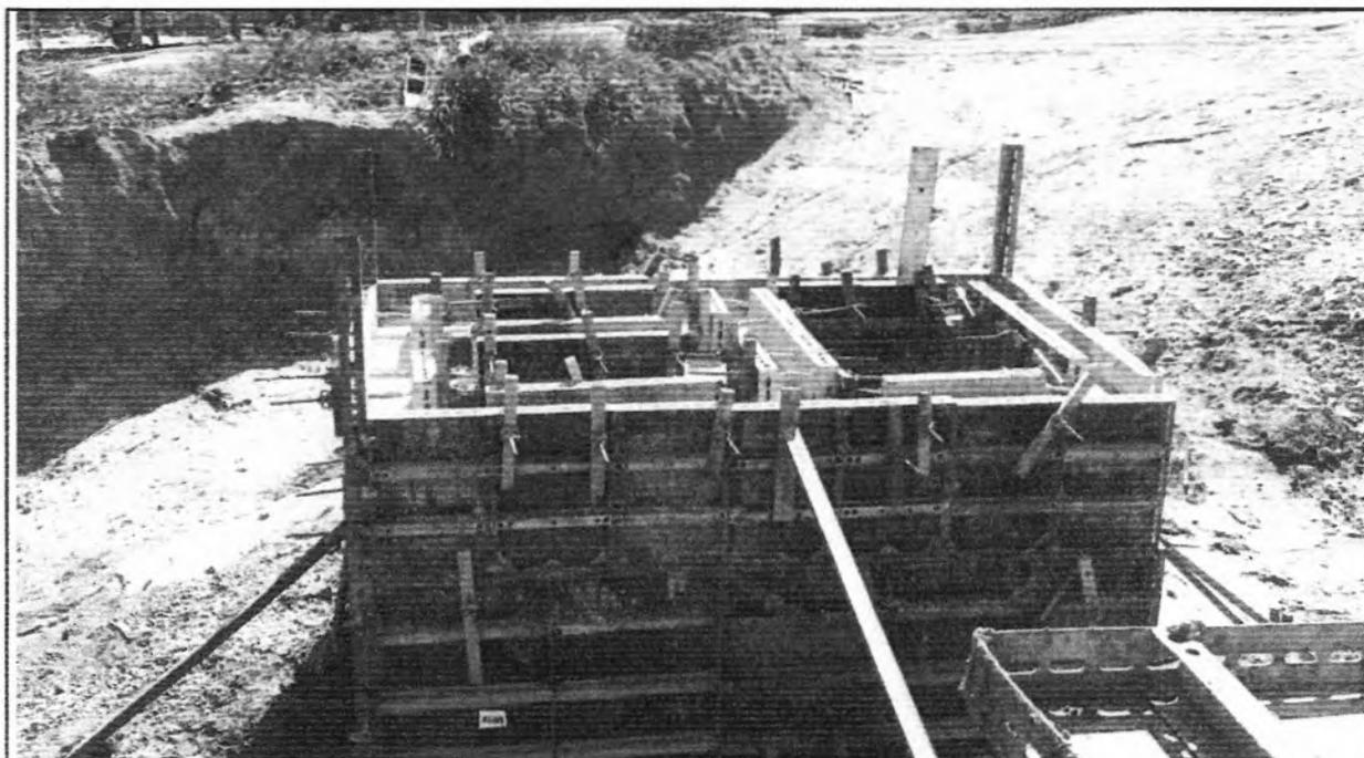
**Descrição:** Concretagem do último lance de paredes da Caixa de Manobra 1.
