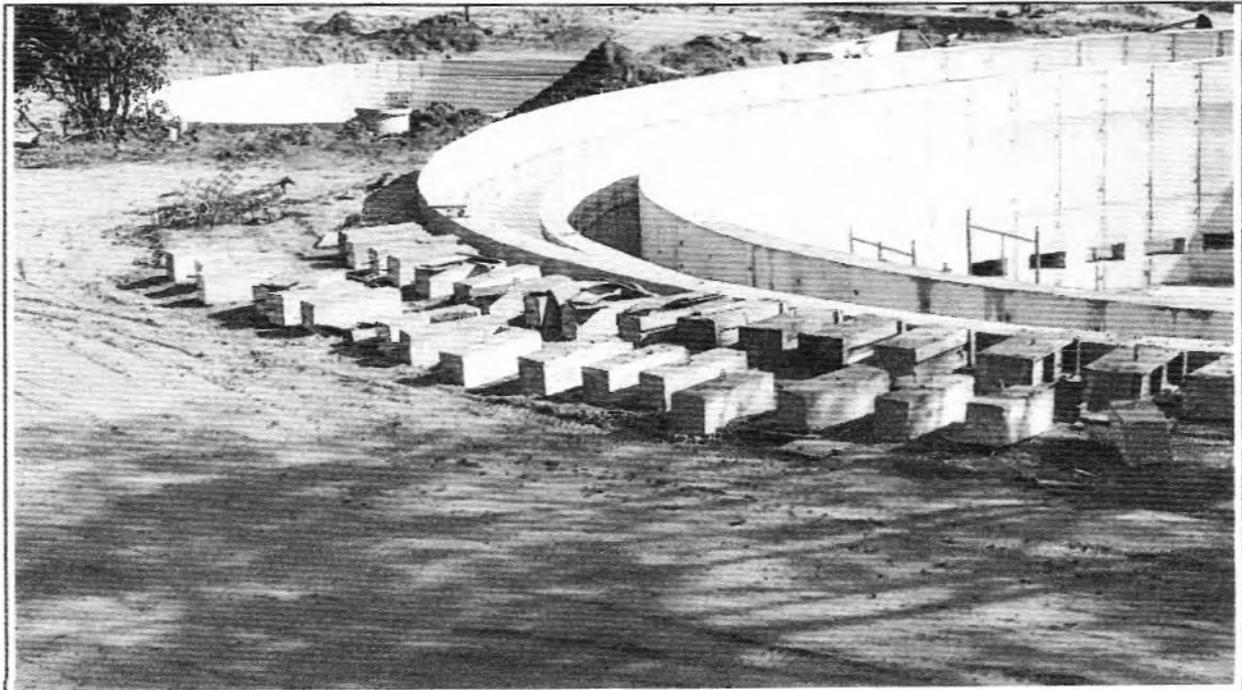
**Descrição:** Concretagem dos pilaretes dos Filtros 1 e 2.
