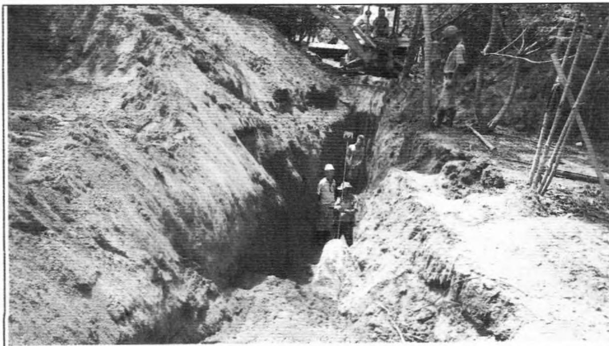
**Descrição:** Execução da linha de recalque da EE Final / Tratamento Preliminar
