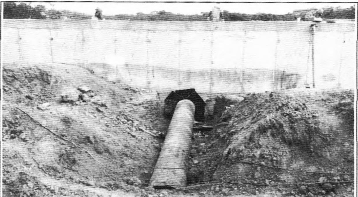
**Descrição:** Assentamento da tubulação (FºFº) da Caixa de Fluxo 1 ao Reator 1.
