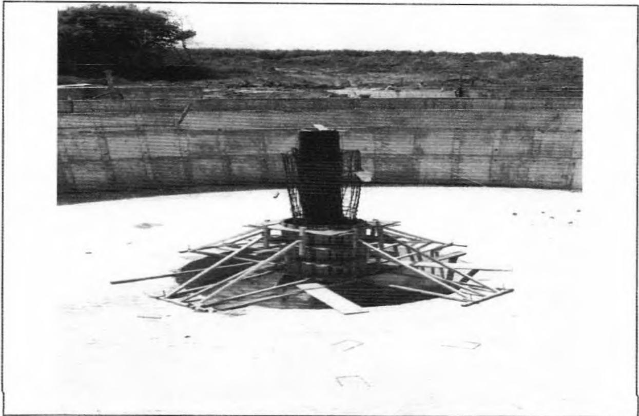
**Descrição:** Montagem da forma do pilar central do Decantador 1.
