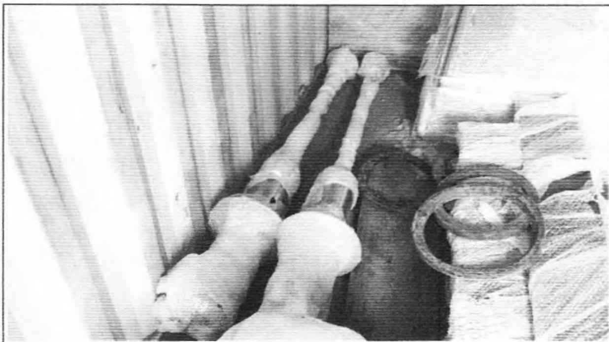
**Descrição:** Misturadores dos Tanques de Polimeros da Casa de Desidratação de Lodo
