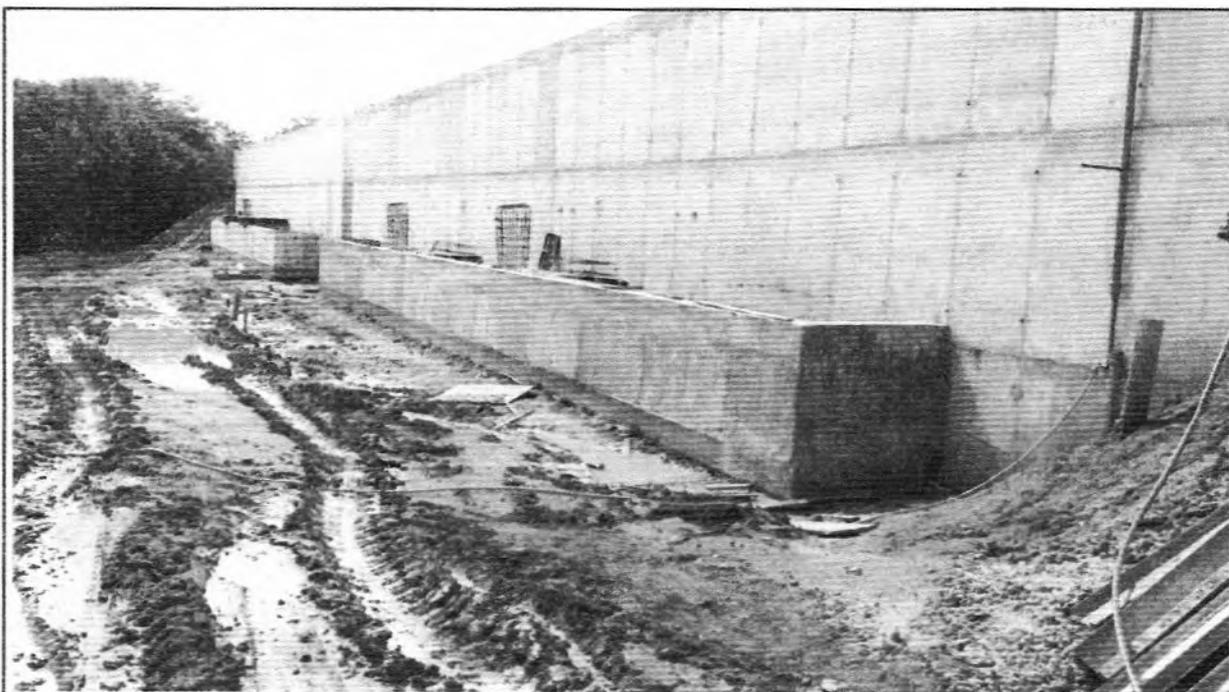
**Descrição:** Concretagem e desforma da Caixa de Escuma do Reator 2.
