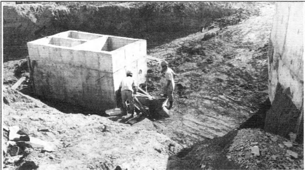
**Descrição:** Ligação da saída de esgoto do Decantador 1 para Caixa de Manobra 1.
