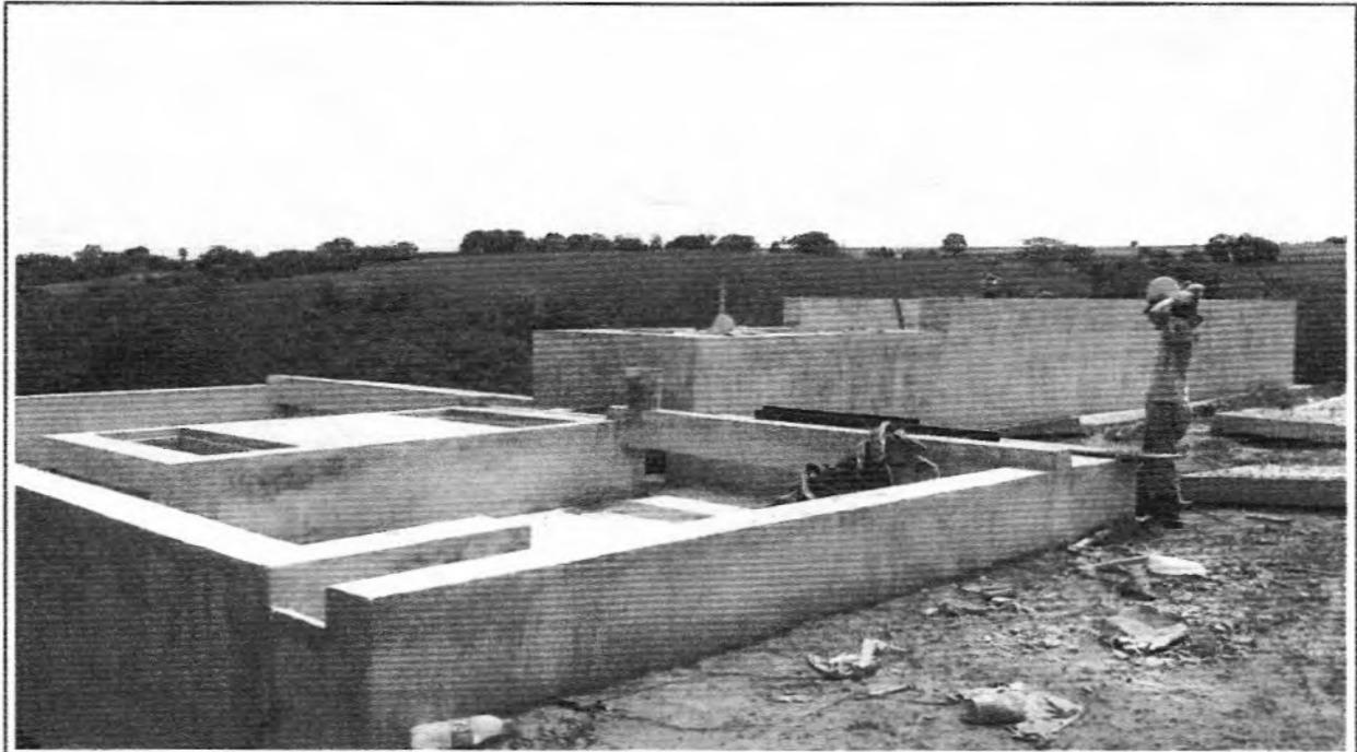
**Descrição:** Impermeabilização das paredes do Gradeamento Fino / Desarenador.
