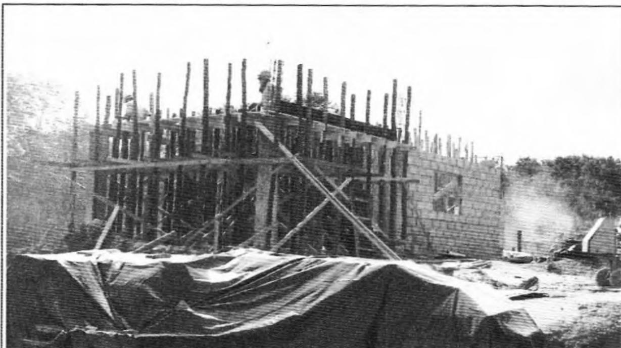
**Descrição:** Cimbramento, armadura e montagem de forma das vigas superiores da Casa Desidratação de Lodo.
