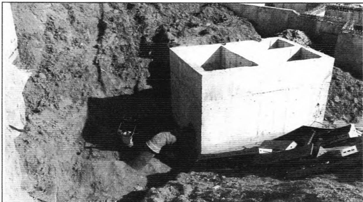
**Descrição:** Ligação da saída de lodo do Decantador 2 para Caixa de Manobra 2.
