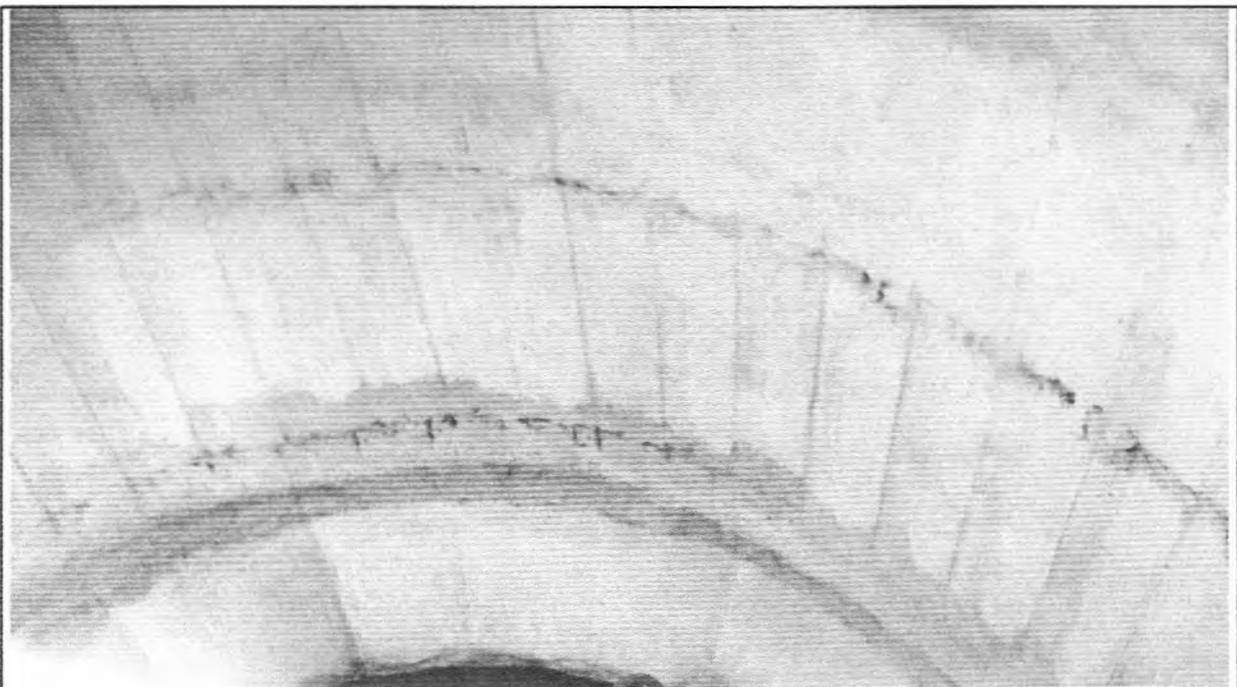
**Descrição:** Impermeabilização das paredes internas da EE Final.
