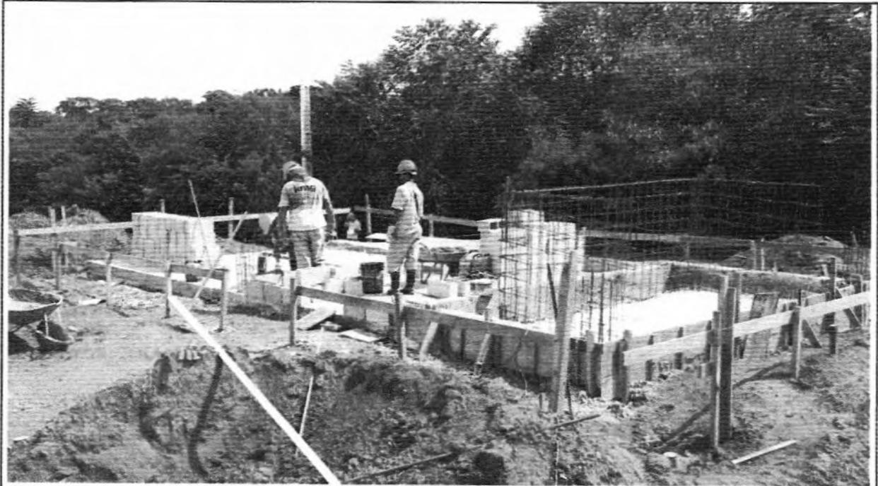
**Descrição:** Concretagem da fundação e laje de fundo da Casa de Desidratação Lodo.
