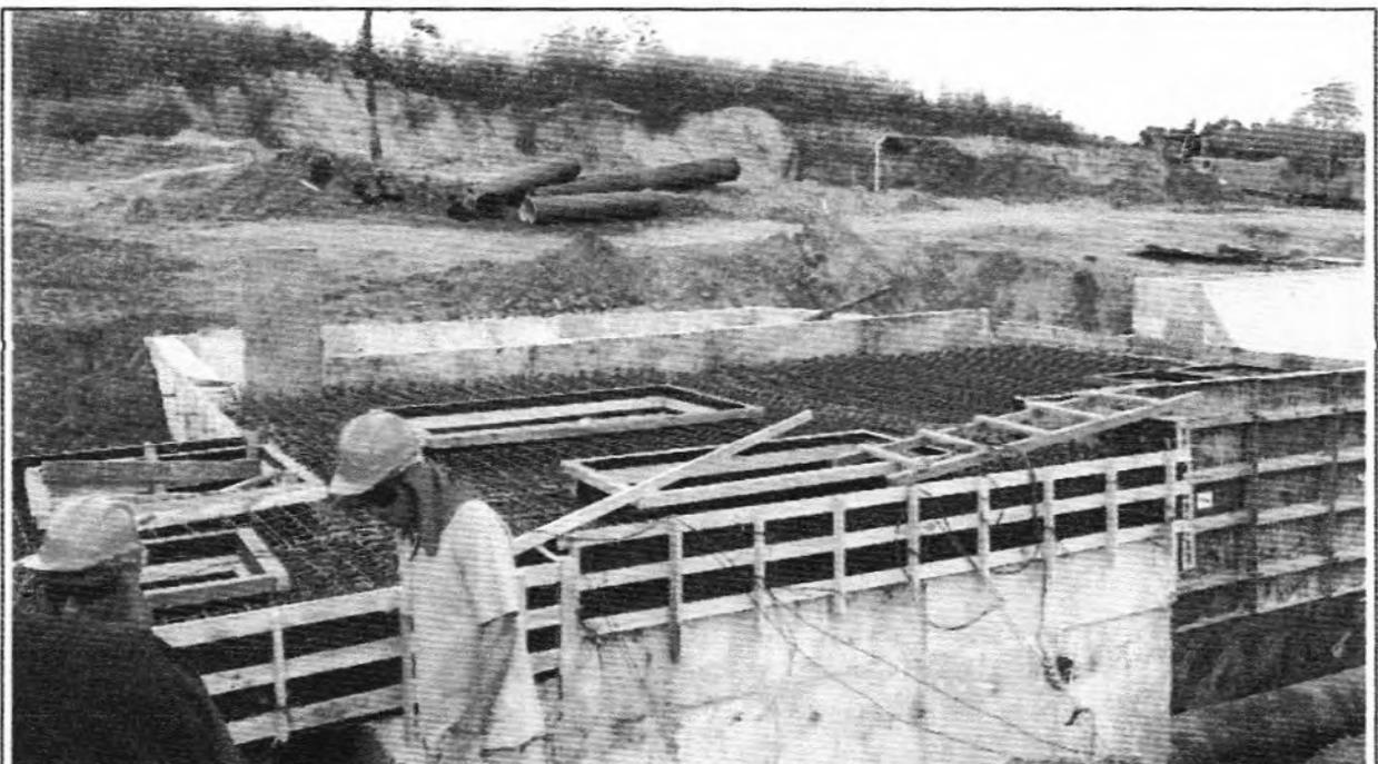
**Descrição:** Armadura e montagem de forma da laje da EE Recirculação.
