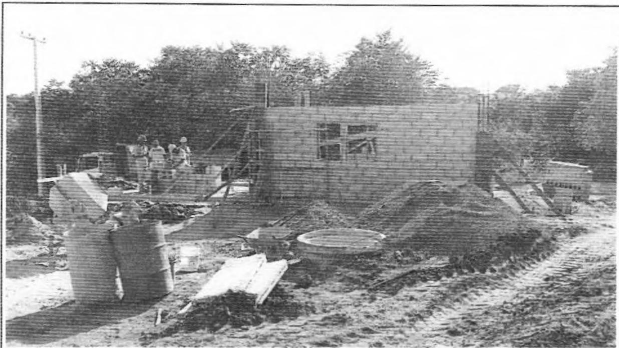
**Descrição:** Execução das paredes da Casa de Desidratação de Lodo.
